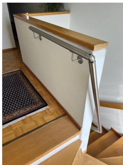
I **corrimano in acciaio**, possono essere installati a parete mediante supporti da avvitare con viti a vista o a scomparsa.
